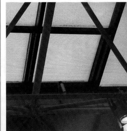
La serigrafia, utilizzata sui vetri di copertura, permette il controllo della luce zenitale, in maniera semplice e formalmente sobria.
